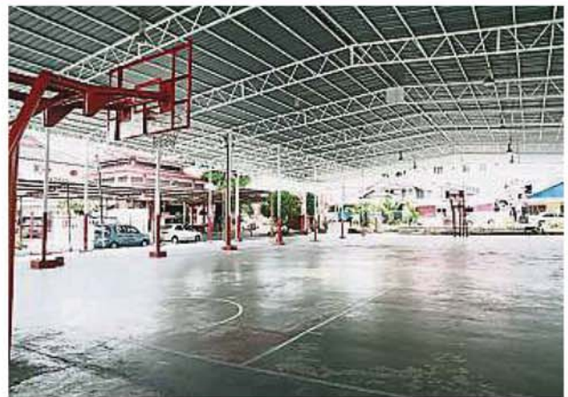
篮球场已完成粉刷屋顶工作，接下来将进行修复地面工程。
