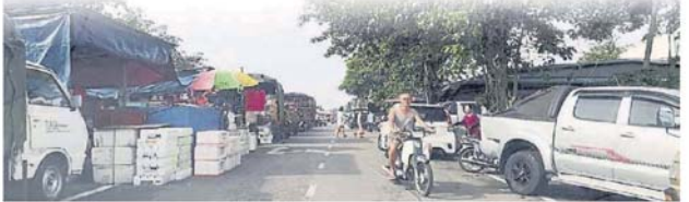
巴板路早市巴刹耗资50万令吉，周一动工整修，工程包括摊位、屋瓦、地面及遮阳棚等。
